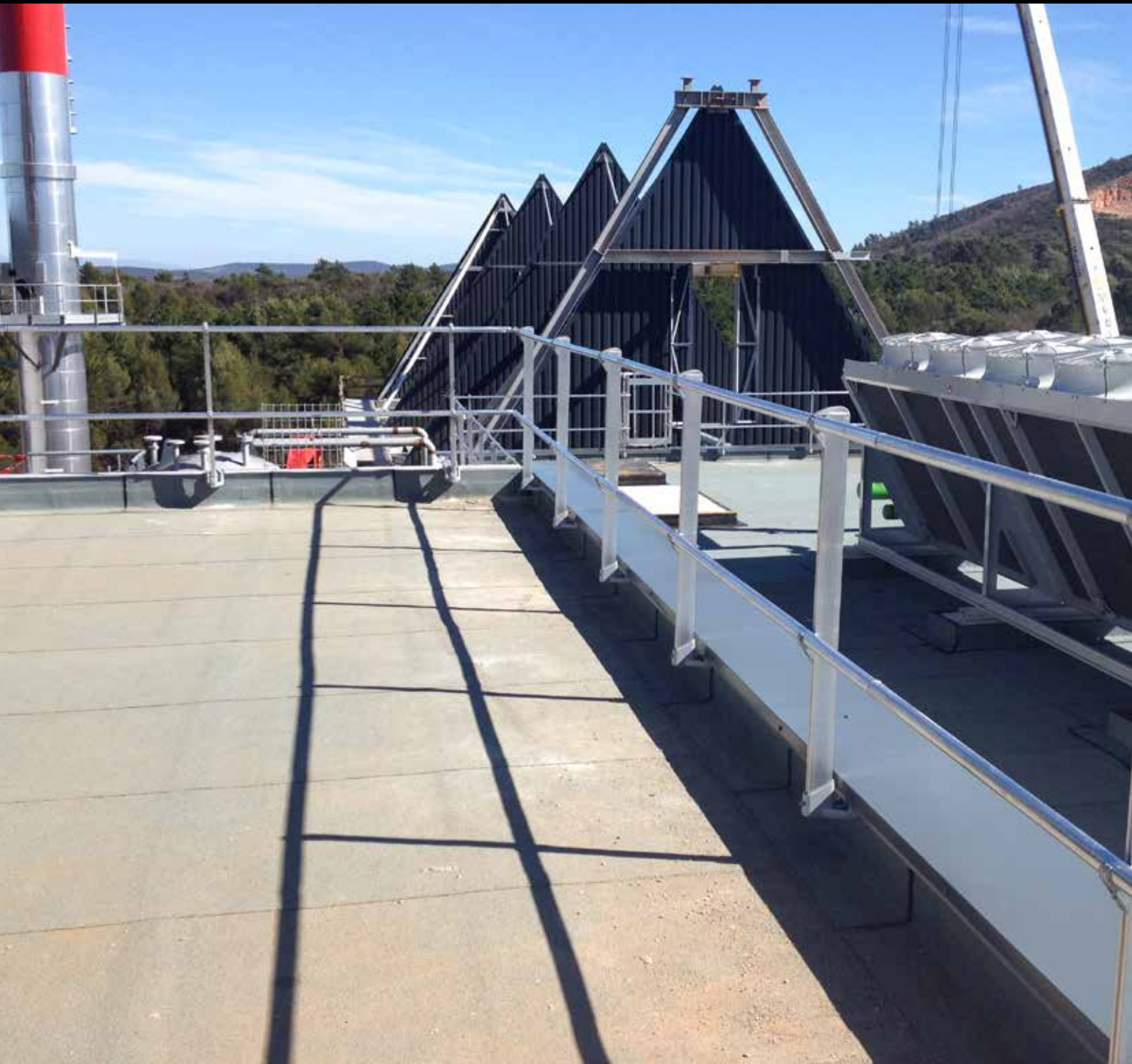
Différentes utilisations possibles selon le type de platine utilisée et la hauteur de l'acrotère
